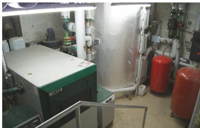
Kesselanlage mit Pufferspeicher
