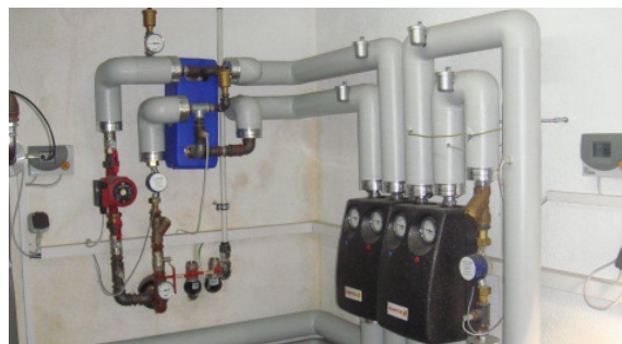
Plattenwärmetauscher und Wärmehähler
