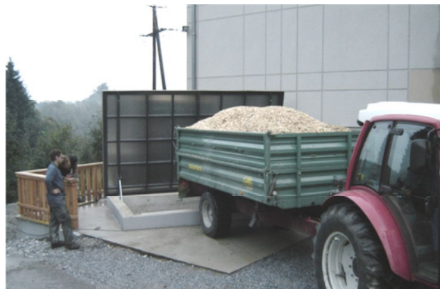
Volksschule St. Martin/W. mit Hackgutlageranbau
