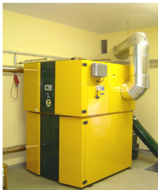
150 kW-Kesselanlage
